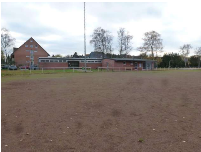
Abb. 6: Eingeschossiges Umkleidegebäude im südöstlichen Teil des Plangebietes
