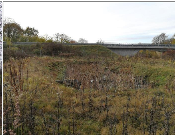
Foto 6: Regenrückhaltebecken im Nordwesten (2019)
