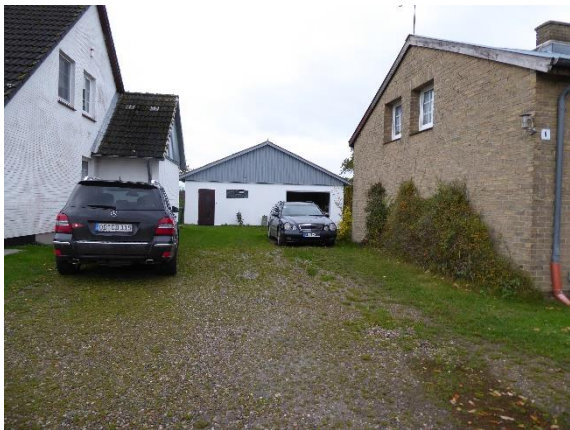
Rückwärtiges Gebäude ehem. Schlachtgebäude Königstein 8/9
