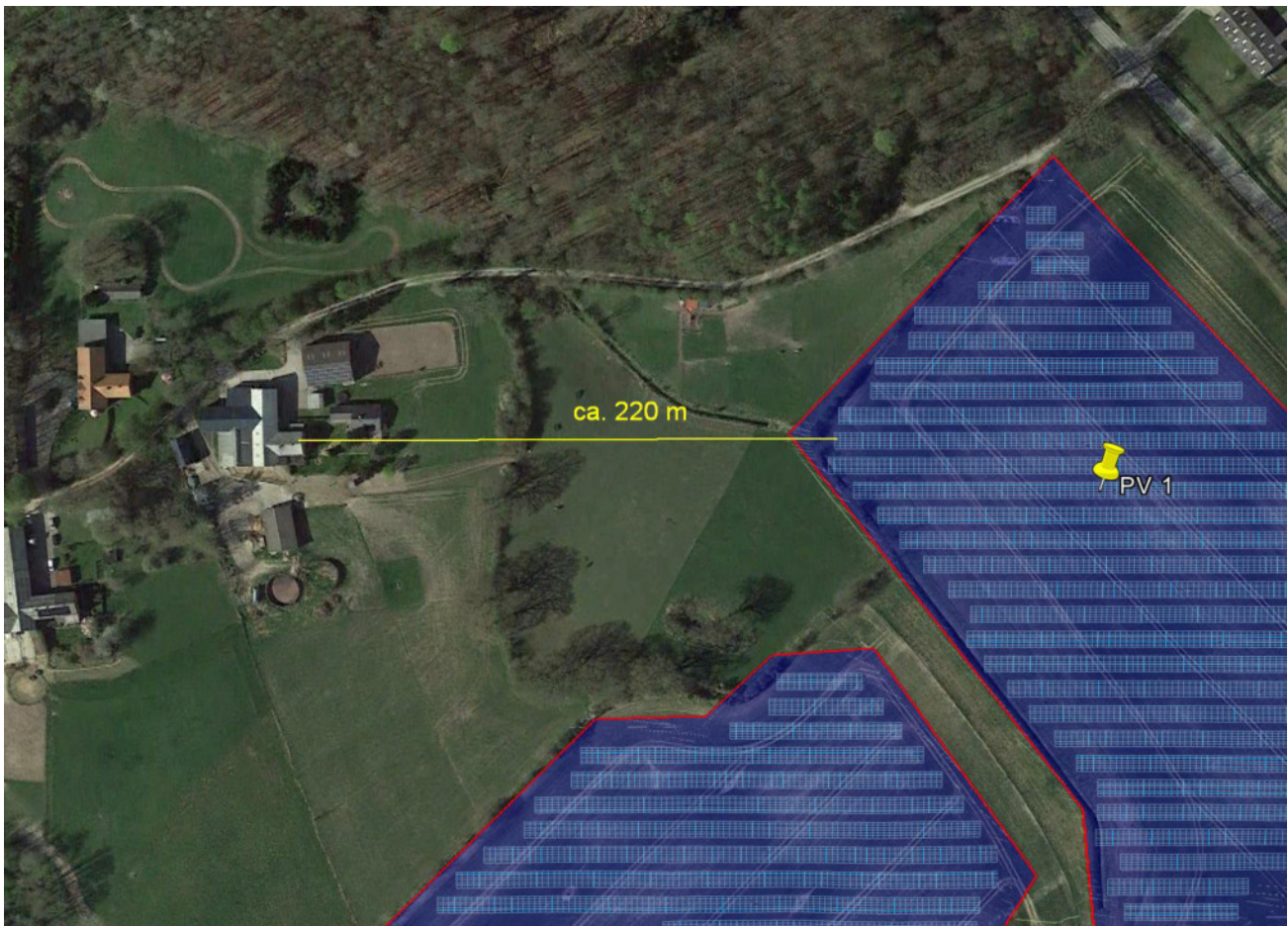
Bild 2.2.1: Nördlicher Teil der PV Anlage und Umgebung (Quelle: Google Earth/SolPEG)
