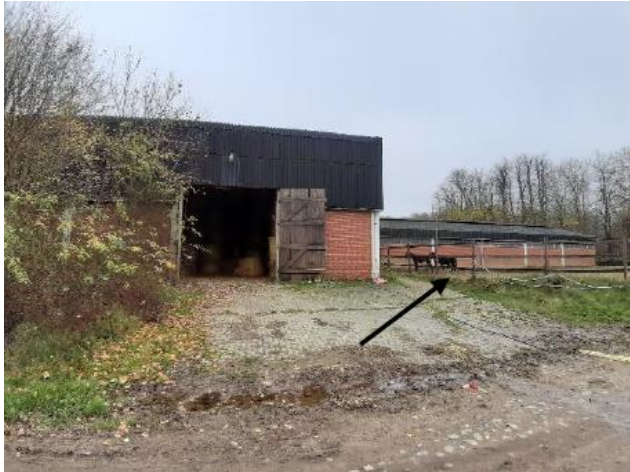
Foto 48: Blick auf Stallgebäude und westlichen Pferdeauslauf
