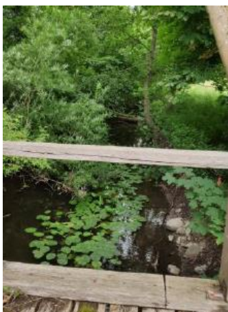
Foto 22: Ufersituation östlich der Holzbrücke
