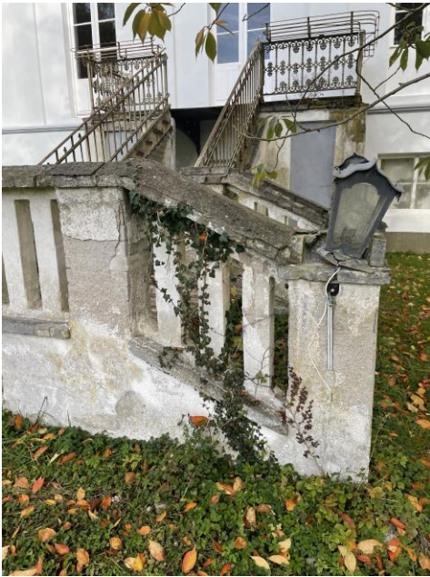
Fußpunkt der Freitreppe Südseite
