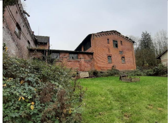
Garten mit teilw. verfallenen Gebäuden, Habitat für Fledermäuse, Gebäude/Nischenbrüter
