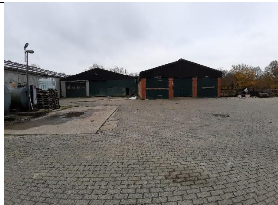
Hoftankstelle und Stallgebäude, Habitat Schwalben, Fledermäuse
