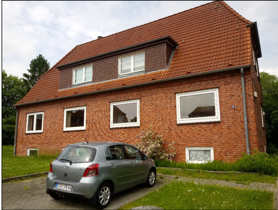
Abbildung 1: Vorderansicht Haus Nr. 6 (Nr. 8 und 10 baugleich), Krüppelwalmdach mit Gaube
