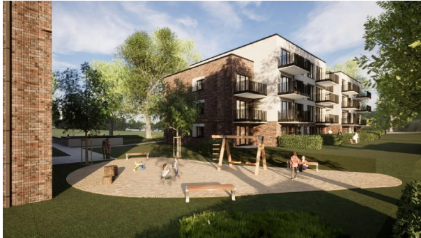
Blick nach Nordost - Haus 2
