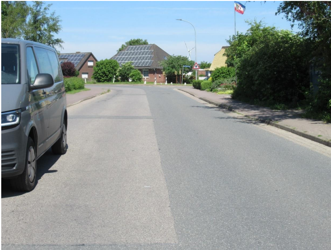
Abbildung 15-3, Nordseestraße auf Höhe der Zufahrt zum Plangebiet, Blickrichtung Westen
