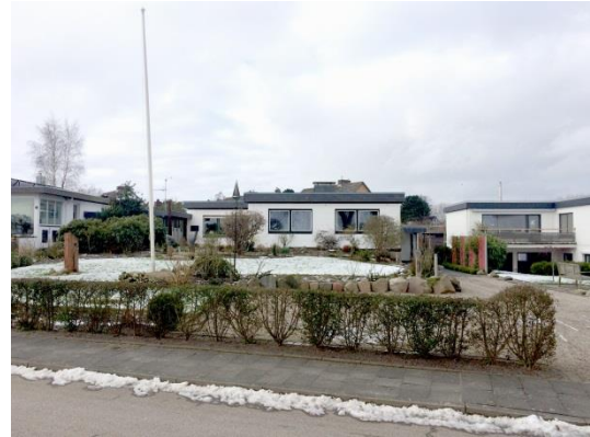
Abbildung 11: Vorgärten der Bungalowbauten
