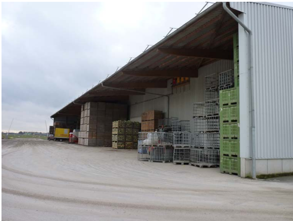
Abbildung 5: Die Möhrenhalle von der Ostseite
