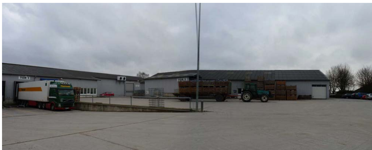
Abbildung 2: Blick Richtung Westen und Norden über die Warenannahme Godeland sowie die Halle der Firma Beckmann
