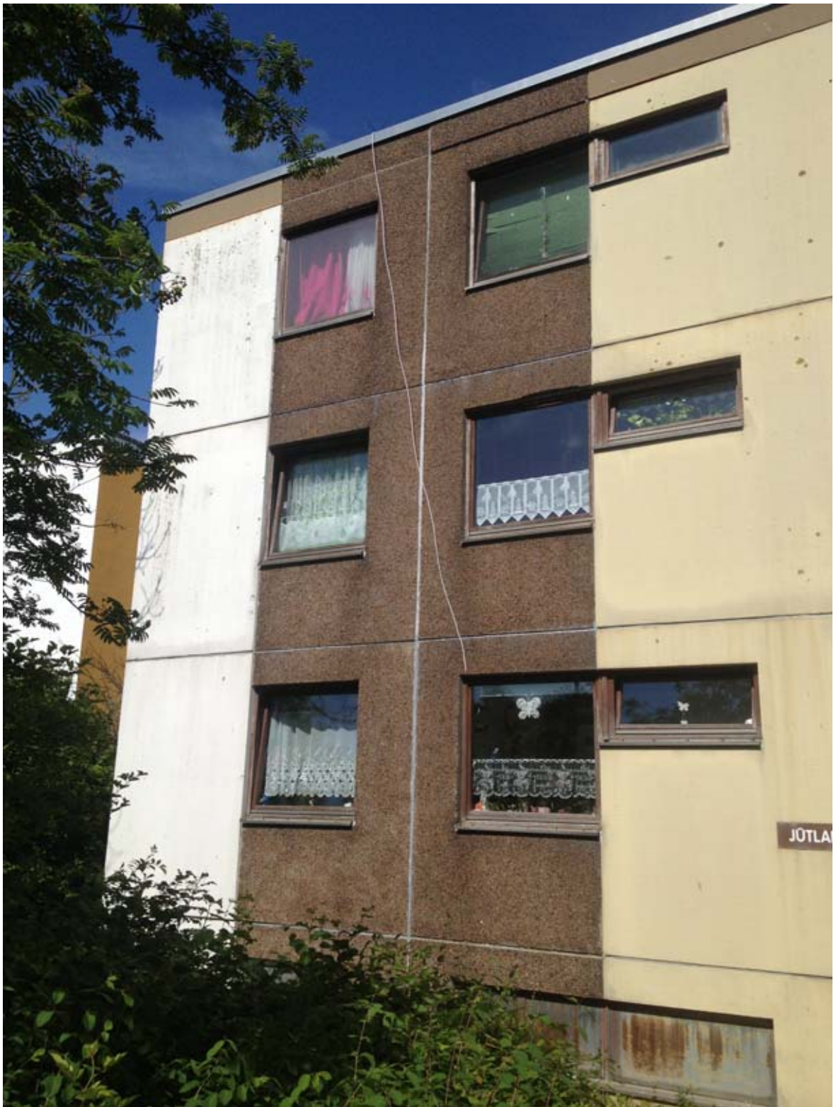
Abb. 2: Teilansicht der vorderen Fassade des Gebäudes Passatring 1-3 (30.06.2022; Dampf).
