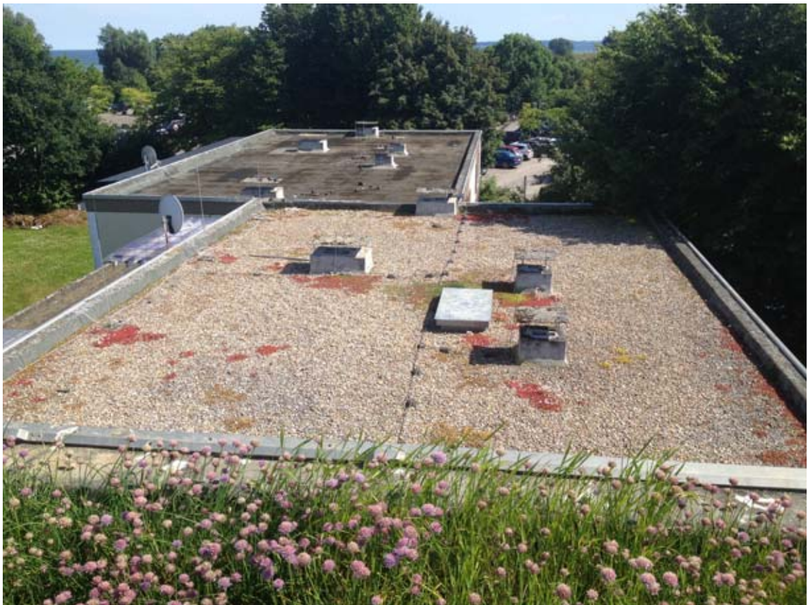
Abb. 4: Vorne der Dachbereich von Nr. 2 (bekiest und punktuell begrünt) und hinten der Dachbereich von Nr. 3 (unbekiest und unbegrünt; 30.06.2022; Dampf).
