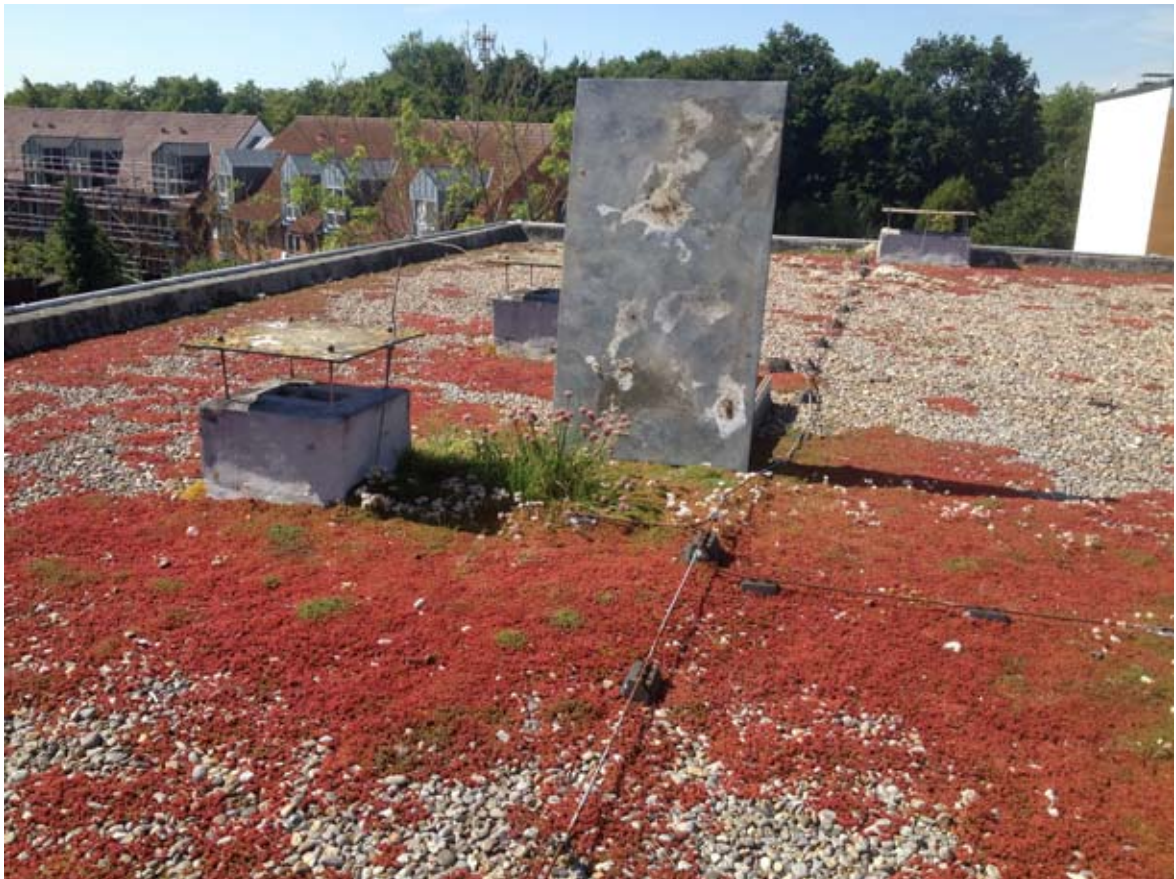
Abb. 5: Der bekieste und begrünte Dachbereich von Eingang Nr. 1 mit einem Silbermöwen-Nistplatz neben dem Schornstein (das zweite Nest befindet sich nicht sichtbar neben einem anderen Schornstein; 30.06.2022; Damp).
