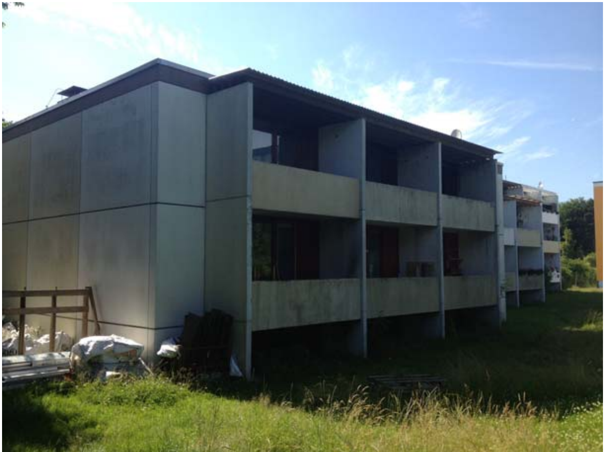
Abb. 3: Rückansicht des Gebäudes Passatring 1-3 (30.06.2022; Dampf).
