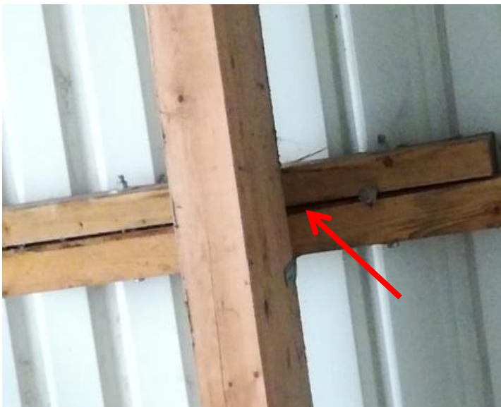
Abb. 4: Potenzielles Spaltenquartier im Dach einer Halle
