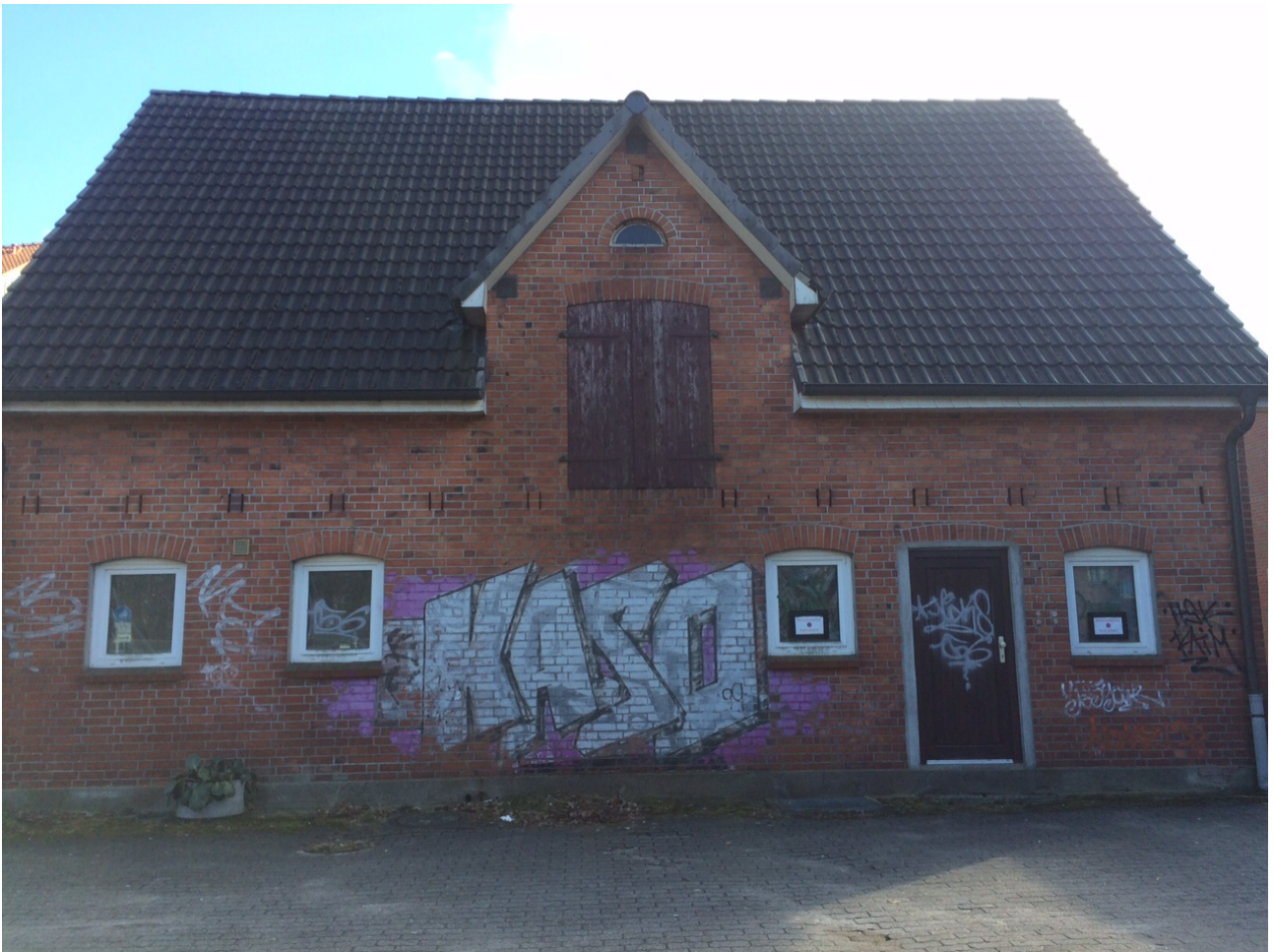
Photo 1: Gebäude B, Nordseite mit Mauerschlitzen.
