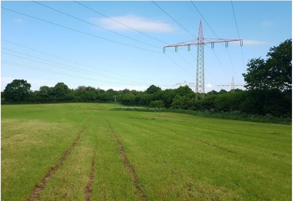
Abb. 2.5 Strommasten südwestlich des Vorhabengebietes (Blickrichtung: Nordwesten, Bild: OPI, Datum: 26.05.2025).
