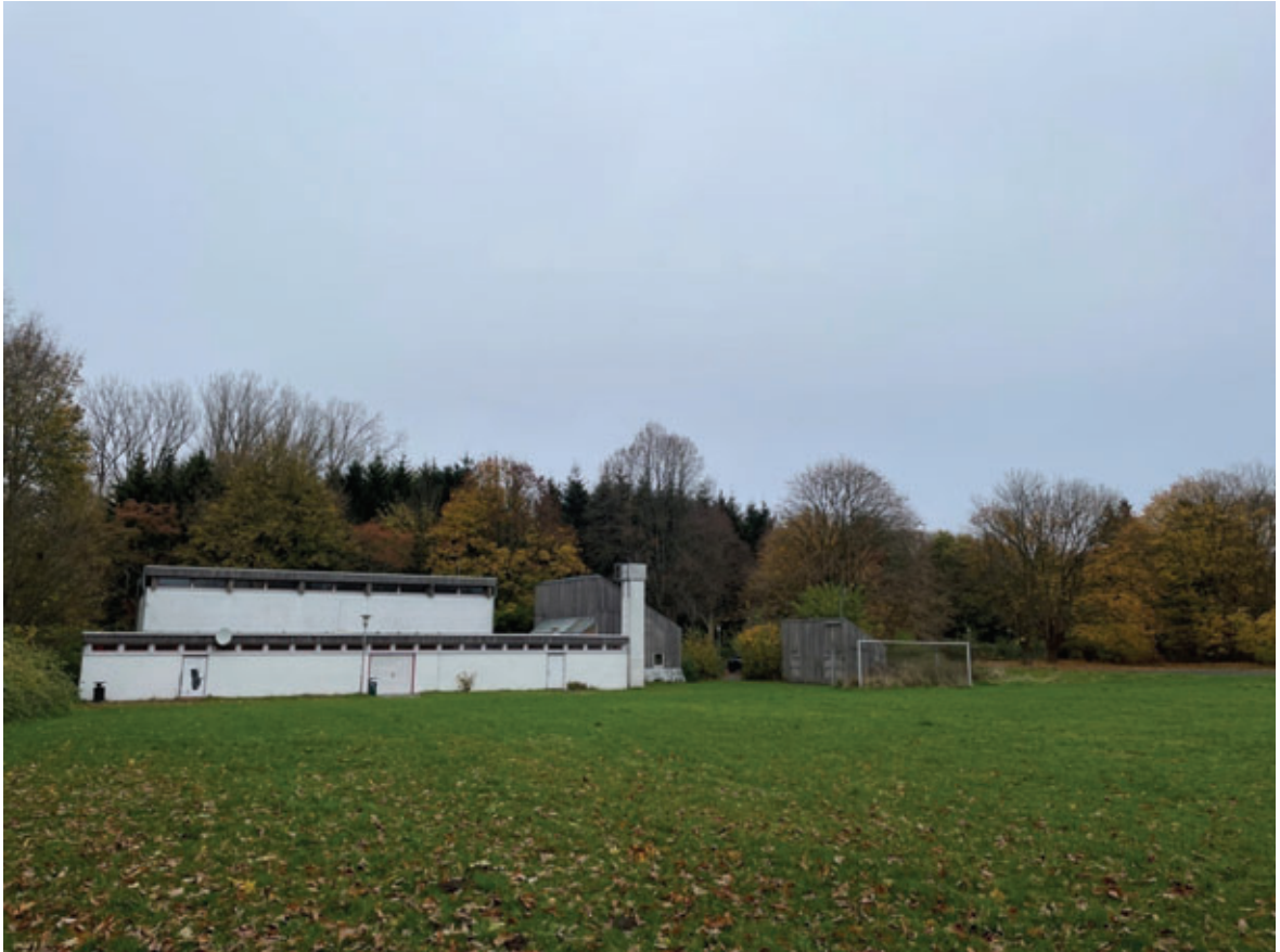
Abb. 5: Sporthalle Haus Nr. 21a mit an- und neugebauten Schuppen (Haus Nr. 21a; 05.11.2024).
