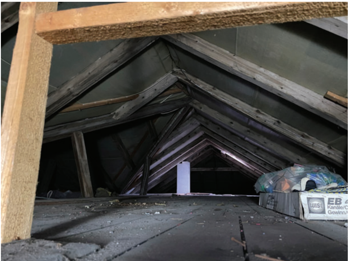
Abb. 4: Dachboden von Haus Nr. 21 (05.11..2024).
