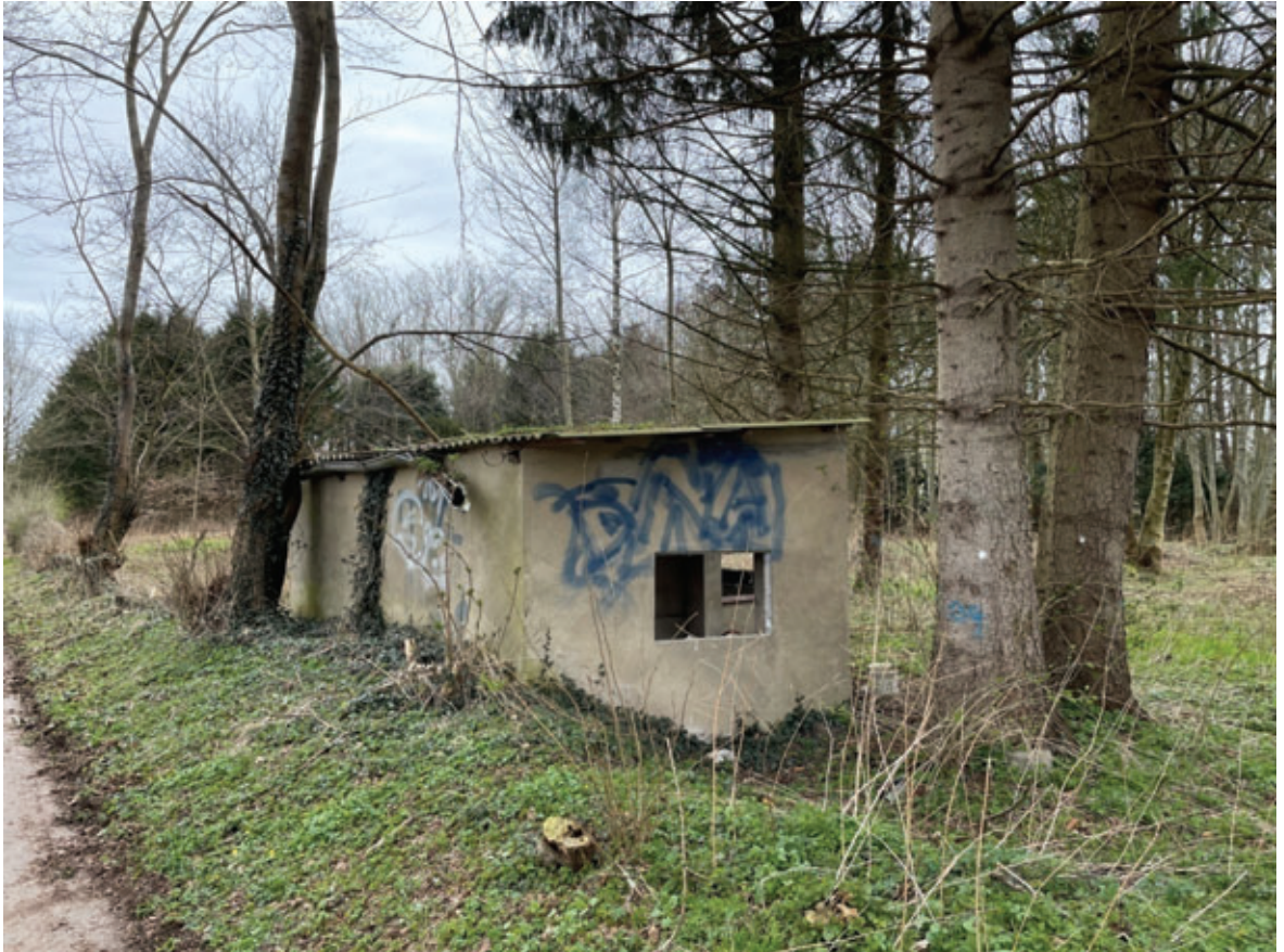
Abb. 11: Ehemaliger Kleingartenbereich mit Laube (28.03.2023).
