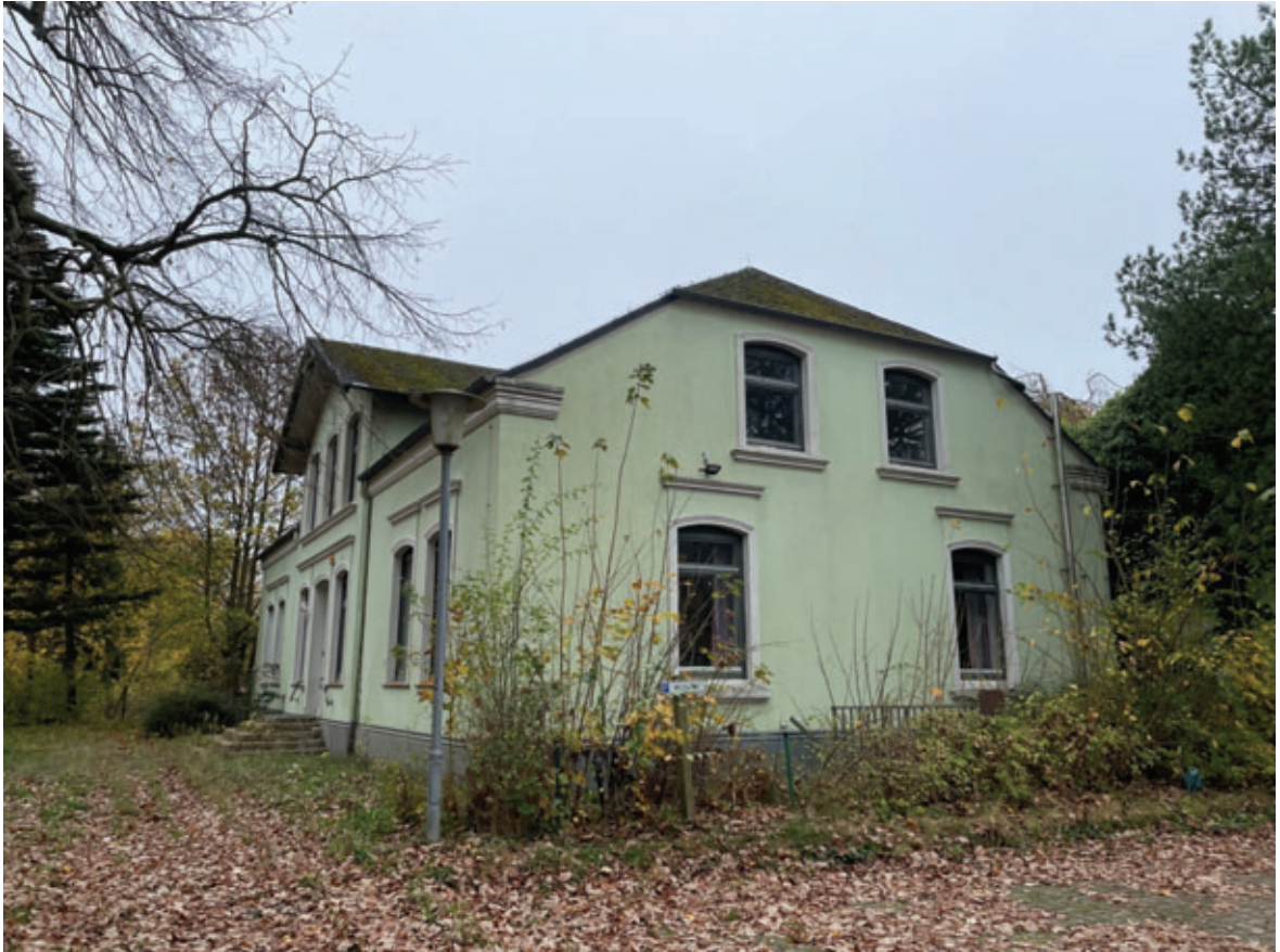
Abb. 3: Haus Nr. 21 auf dem Grundstück St.-Jürgener-Straße 21 (05.11.2024).
