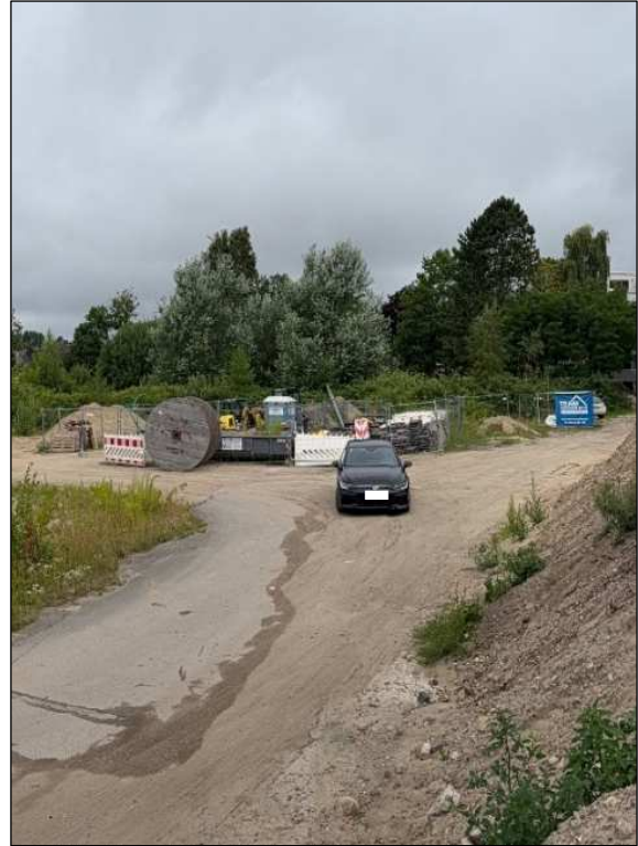
Abb. 4: Abbruchstelle Gebäude 1 aus: eigene Aufnahme, 2026
