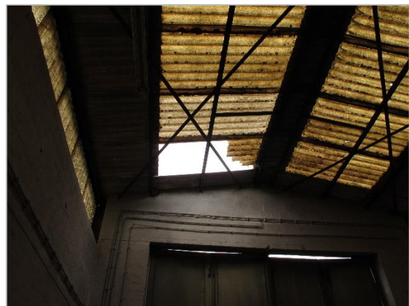
Foto 8: Blick auf den Dachbereich der Halle von Gebäude Nr. 2; Brutstandort des Hausrotschwanzes und Vorkommen von drei alten Rauchschwalbennestern.
