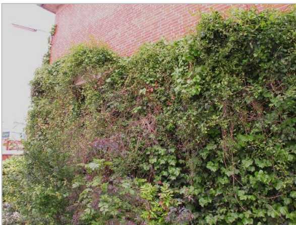
Foto 7: Efeubestand an der Nordfassade des als Bürokomplex genutzten Gebäudes Nr. 3; Brutplatz von mindestens 5 Haussperlingspaaren.
