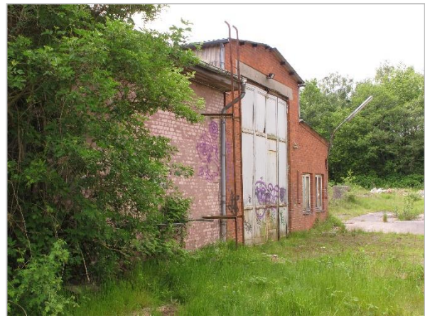
Foto 4: Blick auf die Nordfassade des aus Backstein aufgebauten „Werkstattgebäudes“ (Gebäude Nr. 2) mit randlich aufkommenden Gehölzen.
