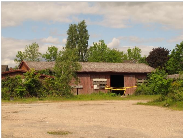
Foto 3: Blick auf das auffällige Gebäude Nr. 1, das bis zuletzt als Lagerhalle genutzt wurde. Um das Gebäude kommen Sukzessionsgebüsch auf.
