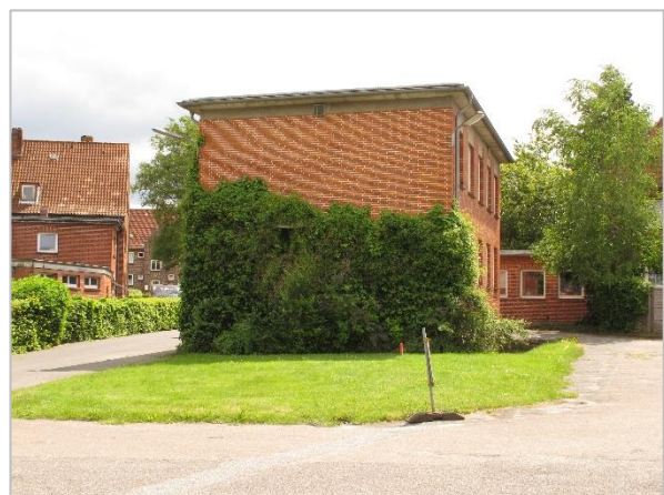
Foto 6: Blick auf das derzeit noch als Bürokomplex genutzte Gebäude Nr. 3 mit alter Fassadenbegrünung aus Efeu (Blickrichtung Süd).
