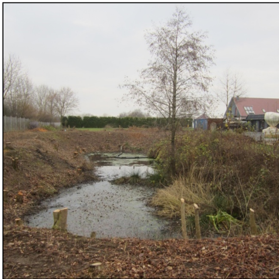
Abbildung 7: Blick von Süden auf das Grundstück mit dem Regenrückhaltebecken (Foto: ALSE 08.12.2020)
