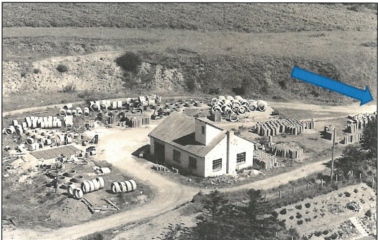
Abb. 3: Betriebsgebäude vor dem Anbau der Erweiterung, die im Jahr 1964 als Flügelbau rechts an das bestehende Gebäude anschließend erfolgte, Blickrichtung etwa Südwest, Ausfahrt zur Bahnhofstraße s. Pfeil
