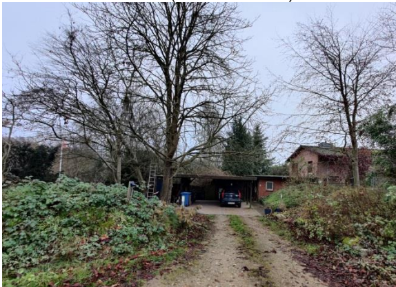
Foto 7: Gebäudekomplex im Bereich, der vermutlich abgerissen werden soll (BBS Nov. 2022)
