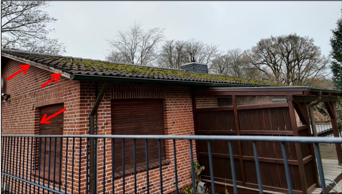
Abbildung 6: Nicht genutztes Wohngebäude mit Spalten und Ritzen an den Dachverkleidungen und an den Holzjalousien der Fenster (s. Pfeile), die als Quartier für Zwergfledermäuse genutzt sein könnten
