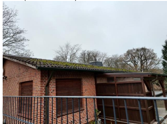
Foto 8: Gebäudekomplex im Bereich, der vermutlich abgerissen werden soll (BBS Nov. 2022)
