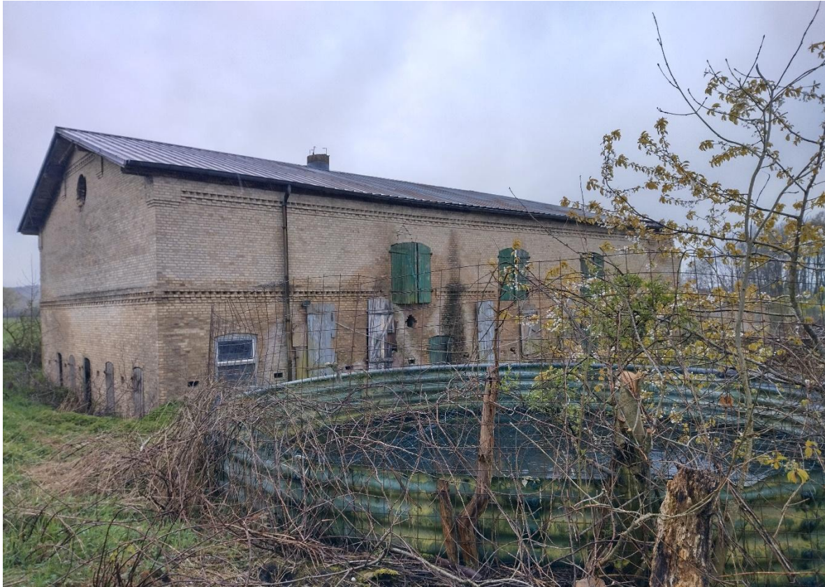
Abbildung 5: Nebengebäude, ehemaliger Stall
