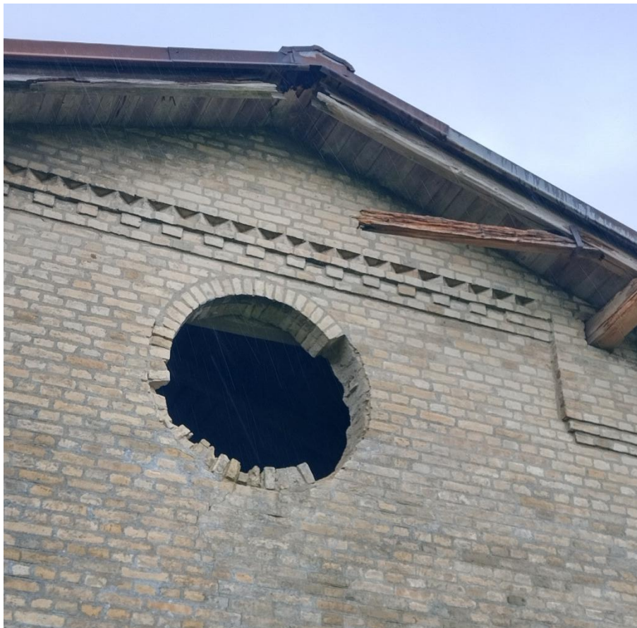
Abbildung 6: Einflugsloch für Eulen auf Südseite des ehemaligen Stalls
