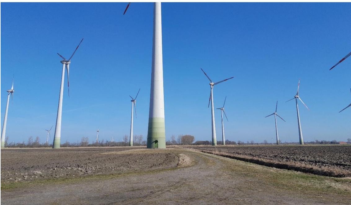
Abbildung 10: Bestands-WEA auf Intensivacker mit teilversiegelter Zufahrt
