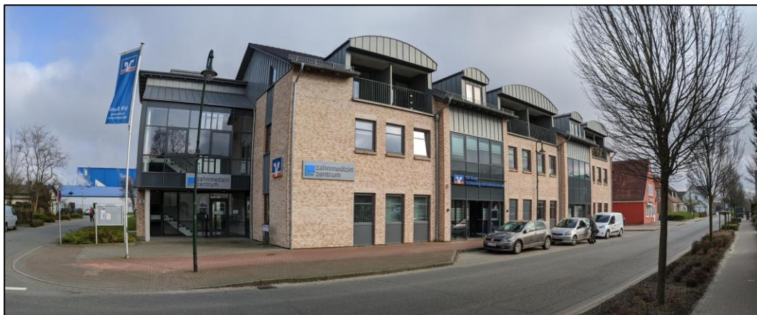
Abbildung 6: Wohn- und Geschäftshaus im Südwesten des Plangebietes
