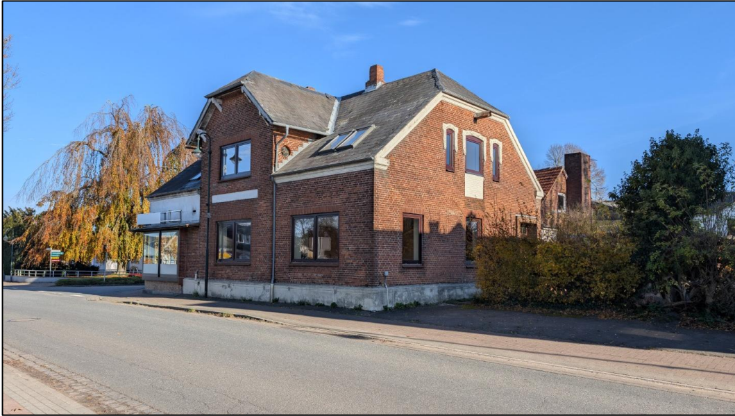
Abbildung 5: Wohn- und Geschäftshaus Schulstr. / Ecke Schleswiger Str.
