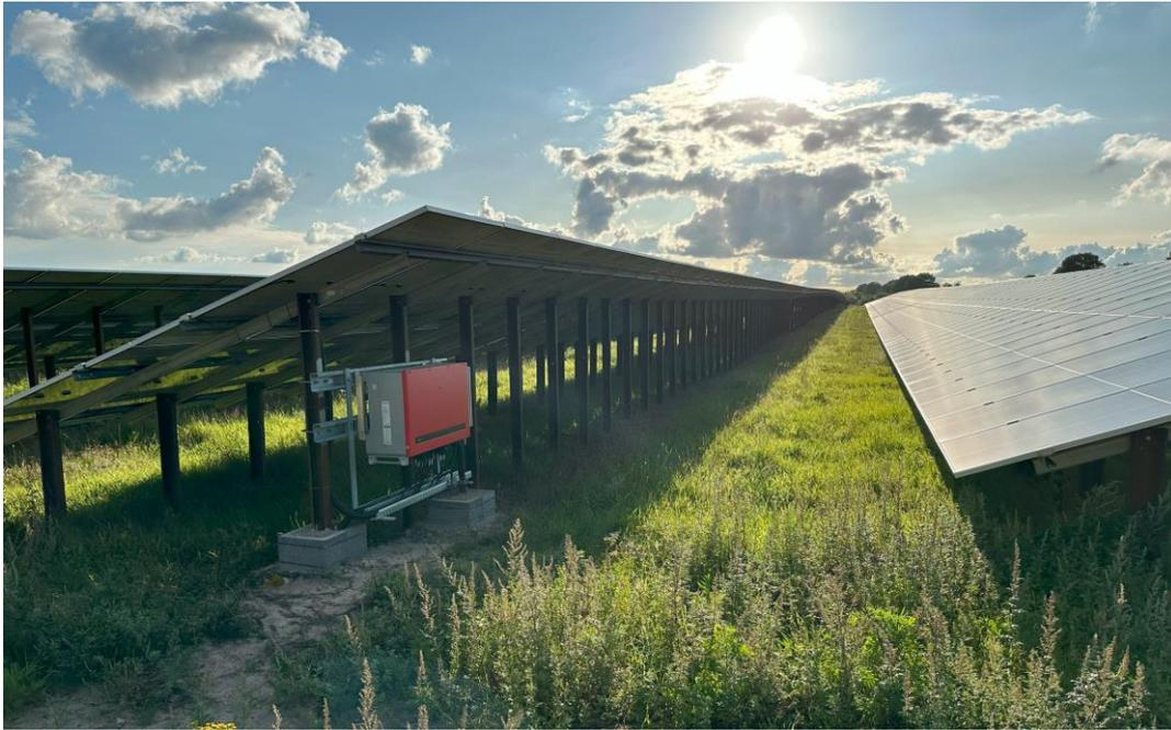
Abb. 7: Beispiel Modultische (Quelle: EE-Plan GmbH)
