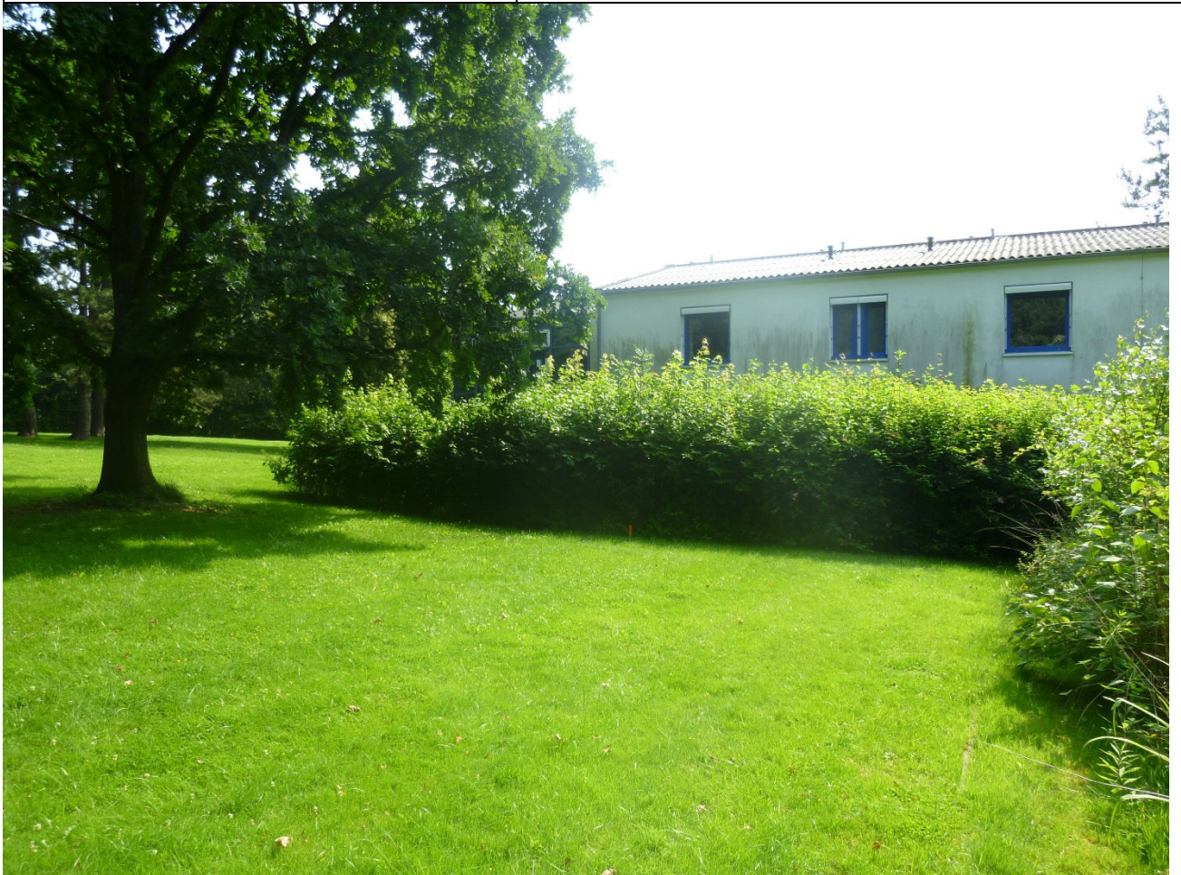
Abbildung 5: Nördlicher Teilabschnitt des Westflügels mit vorgelagerter Zierhecke
