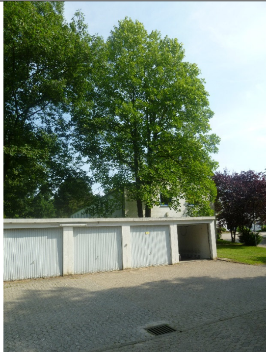
Abbildung 3: Östlicher Teil des Garagenkomplexes, im Hintergrund erkennt man die Stirnseite des Westflügels
