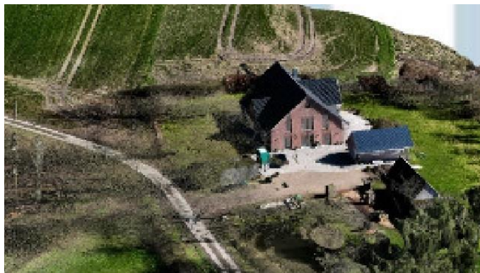
Abbildung 9: Busdorf 16; Quelle: Kundenmaterial
