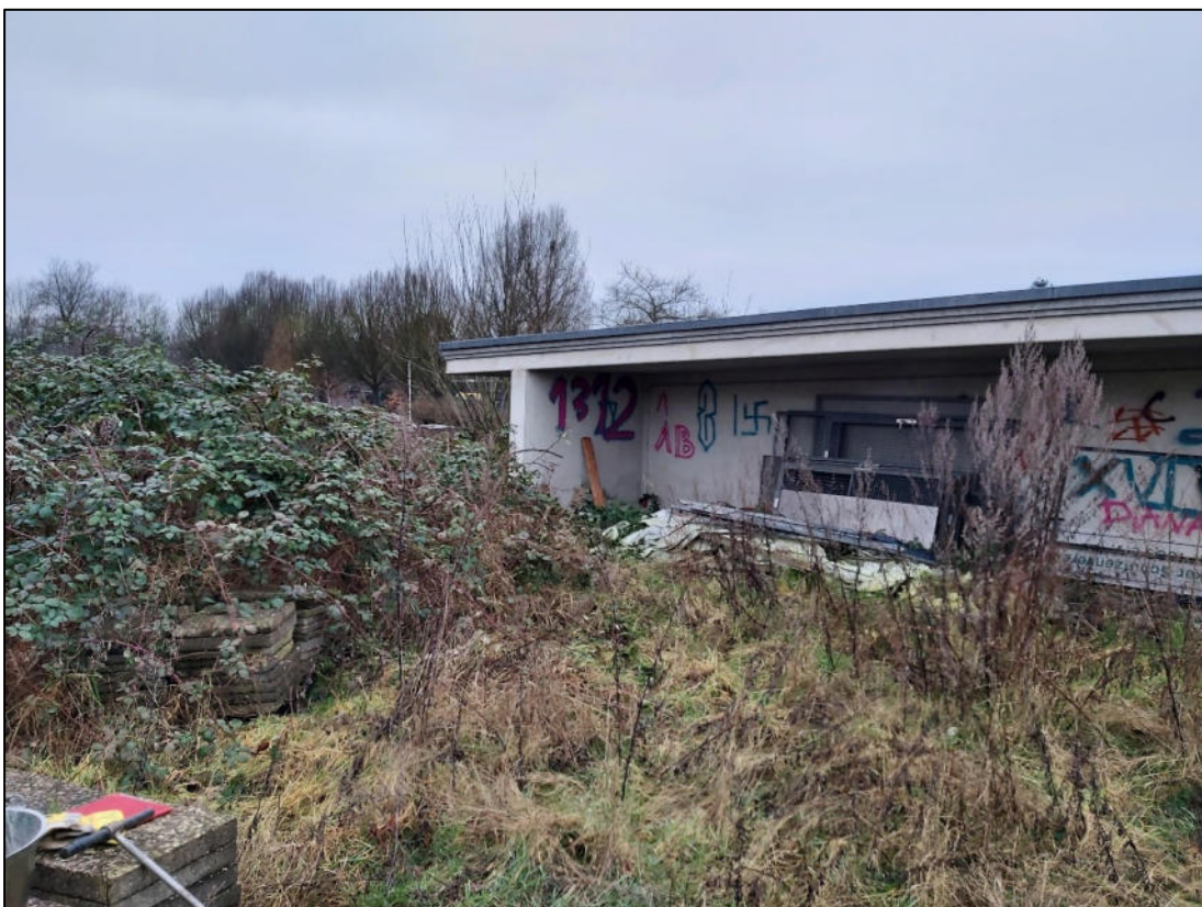
Abbildung 5 Probenahmebereich Teilfläche 1 mit Blickrichtung Schützenplatz, 07.02.2020
