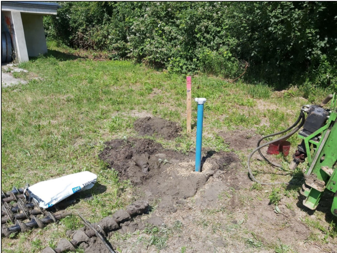
Abbildung 2 Einbau Beobachtungspegel BS 2 / GWM 1, 22.06.2020
