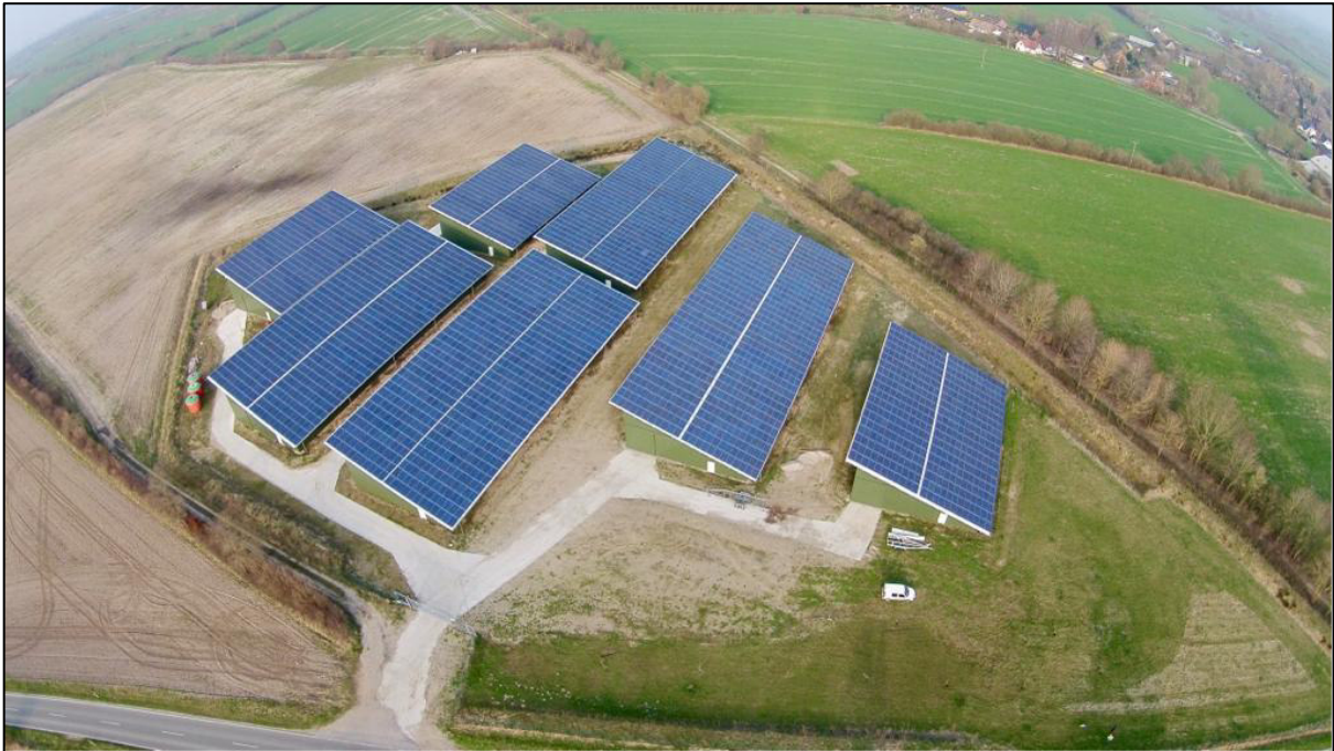
Abbildung 2: Sicht auf die als Teil der Ortslage angenommene PV-Anlage
