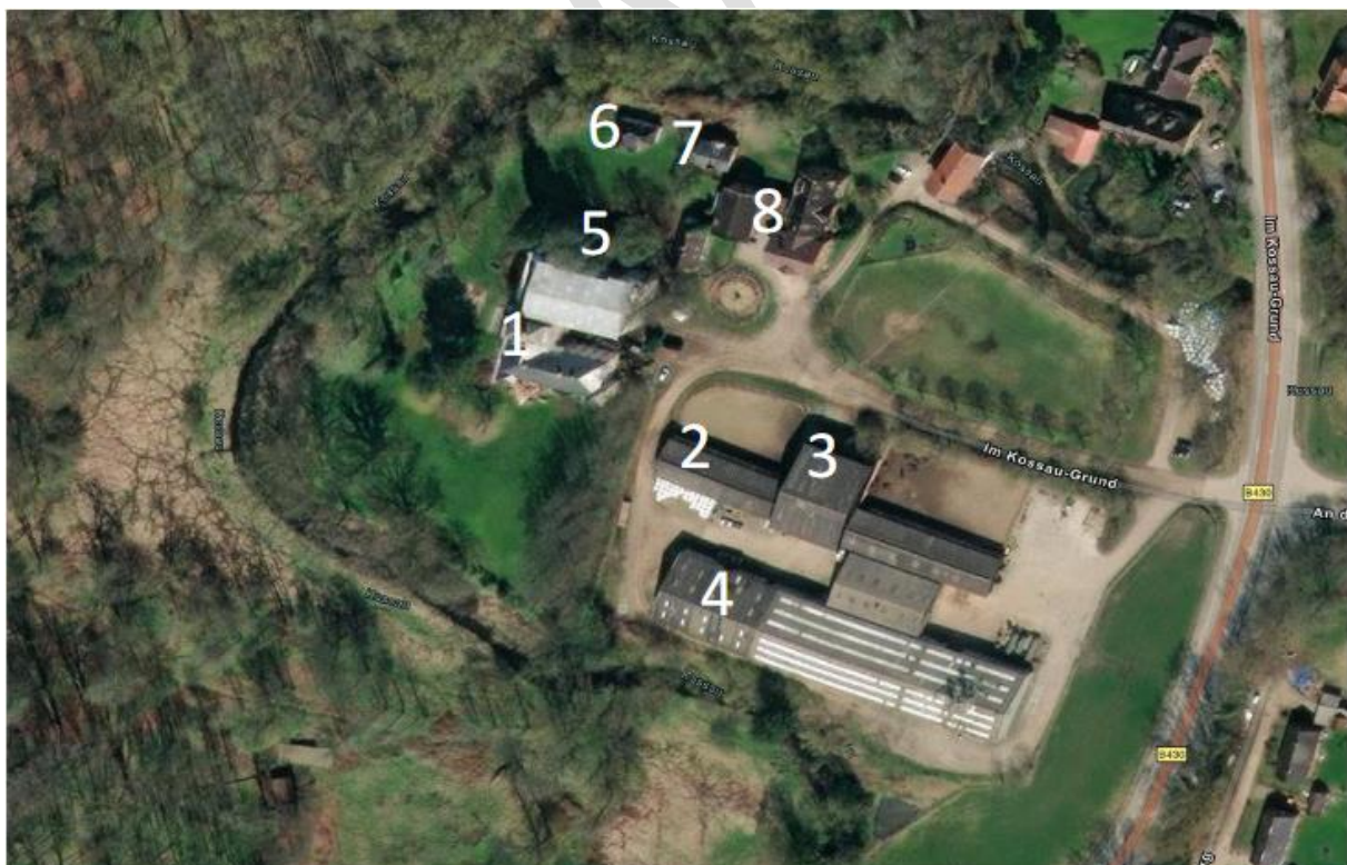
Abbildung 5: Lage der Gebäude mit Fledermausvorkommen (Luftbild Google maps)
