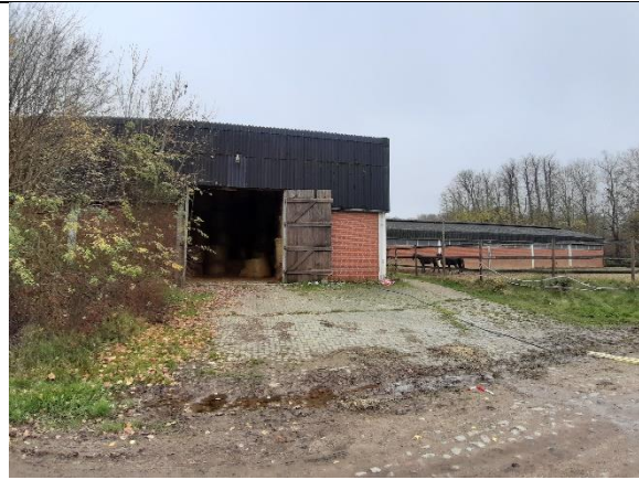
Strohlager und Pferdestall, Habitat für Gebäudebrüter/Nischenbrüter (z.B. Schwalben) und Fledermäuse
