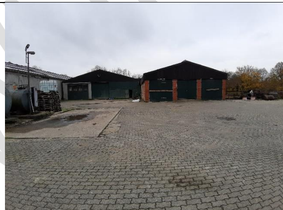
Hoftankstelle und Stallgebäude, Habitat Schwalben, Fledermäuse
