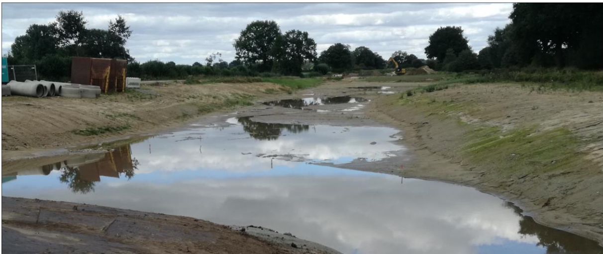
Abb. 5: Retentionsflächenbeispiel bei Todendorf im Bau
