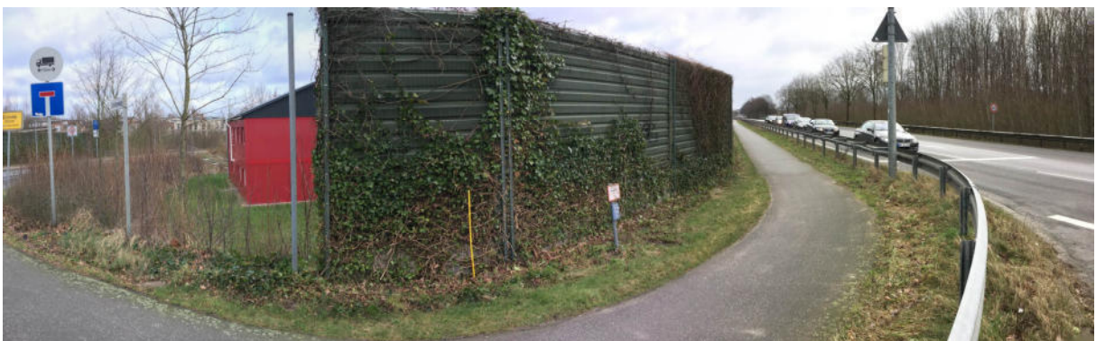
vorhandene Lärmschutzwand an K26 (Blickrichtung Ost)
