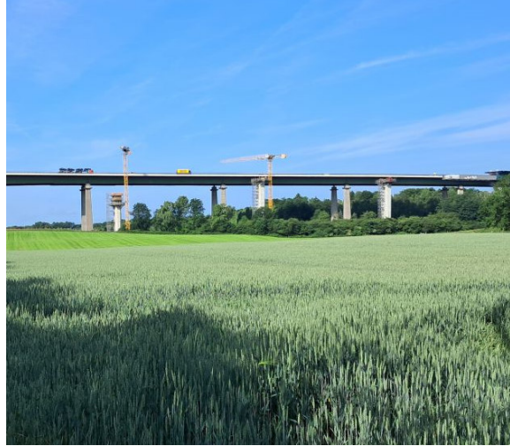
Foto: Ackerfläche im Südwesten des Plangebietes mit der Rader Hochbrücke (einschl. laufendem Neubau) im Hintergrund – Blickrichtung Westen
