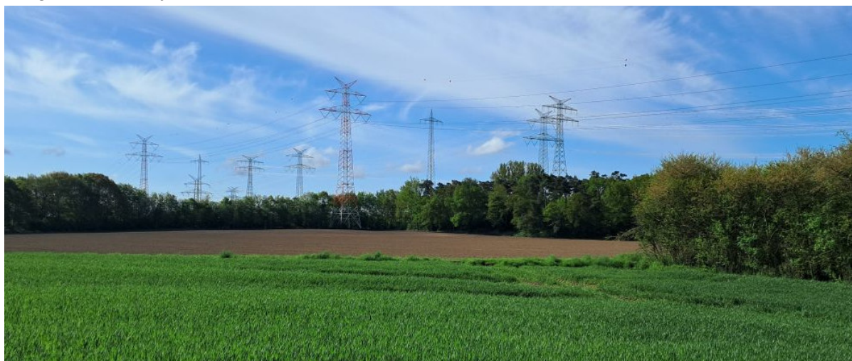
Foto: Ackerflächen des Plangebietes mit über dem Gebiet verlaufenden Hochspannungsleitungen – Blickrichtung Südwesten
