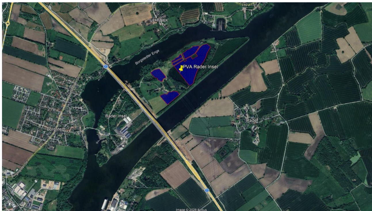
Bild 2.1: Luftbild der PV-Anlage (Quelle: Google Earth / SolPEG)
