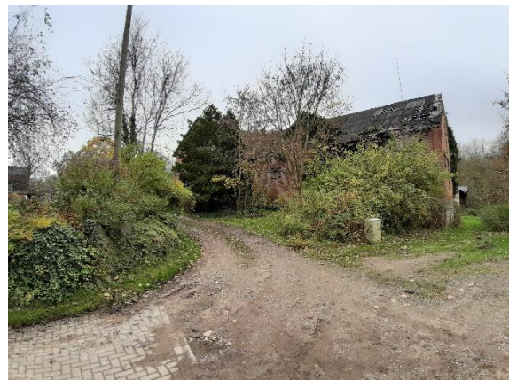
Foto 47: Übergang vollversiegelter Weg neben Teich zu teilversiegelten Fahrflächen
