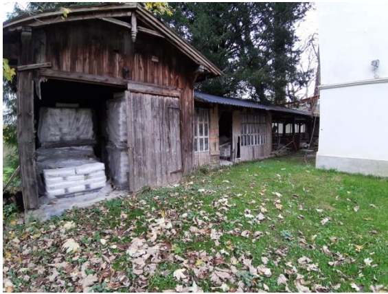
Foto 35: Lagerschuppen über dem Eiskeller
