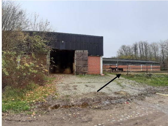
Foto 48: Blick auf Stallgebäude und westlichen Pferdeauslauf
