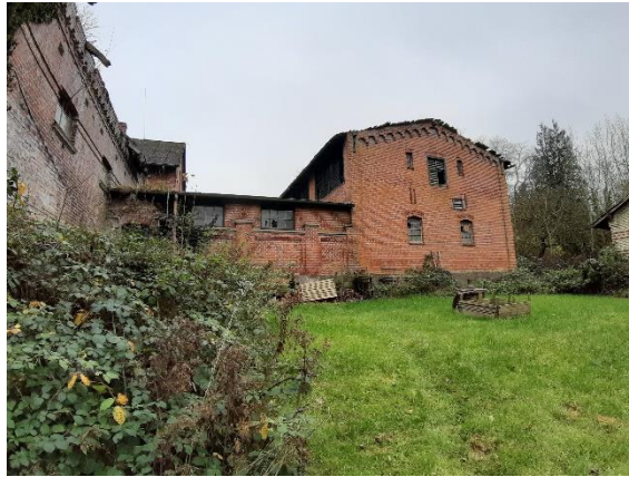
Foto 42: Gartenfläche mit Gebäude im Hintergrund, Blick Richtung Süden
