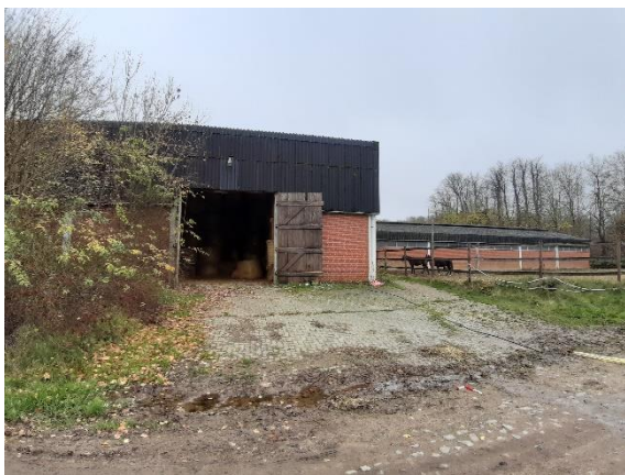
Foto 44: Blick von der Zufahrt mit Pflastersteinresten auf eines der Stallgebäude
