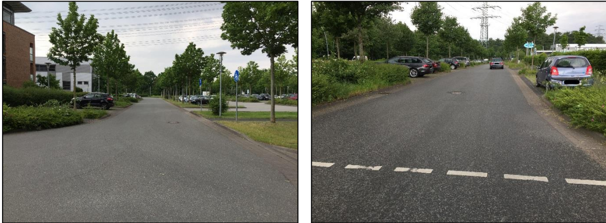
Bild 5.2: Westlicher und südlicher Teil Am Casinopark - Gewerbestraße
