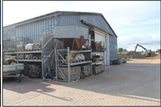
Maschinenhalle Ansicht West mit Lagerregal
