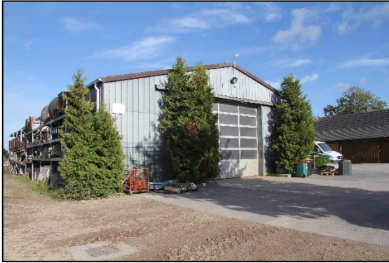
Maschinenhalle Ansicht Ost
