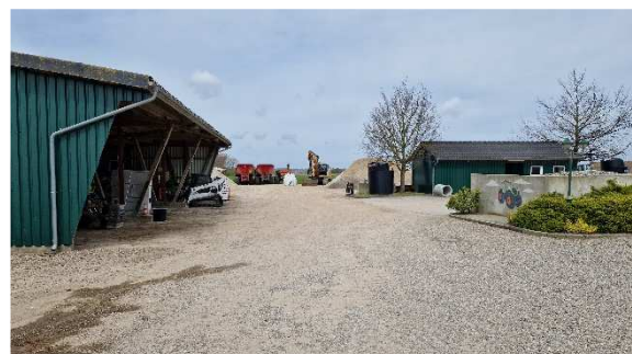
Abb. 8: Betriebshof mit Eichen an der Tankstelle
